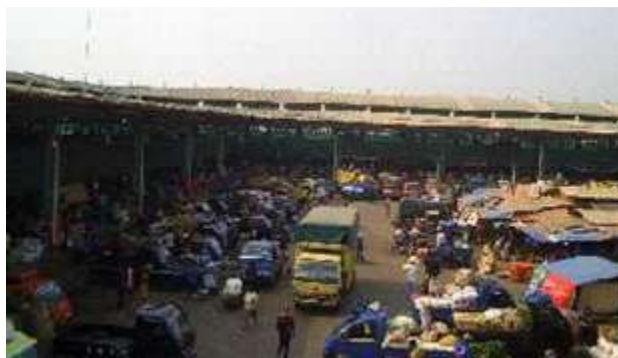
写真2 再整備事業後のジャカルタ青果物中央卸売市場
