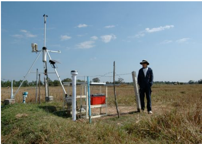
写真3 モニタリングシステム現地設置状況
