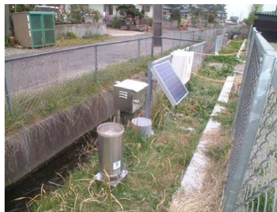
写真 6 PFS-AW の設置状況
