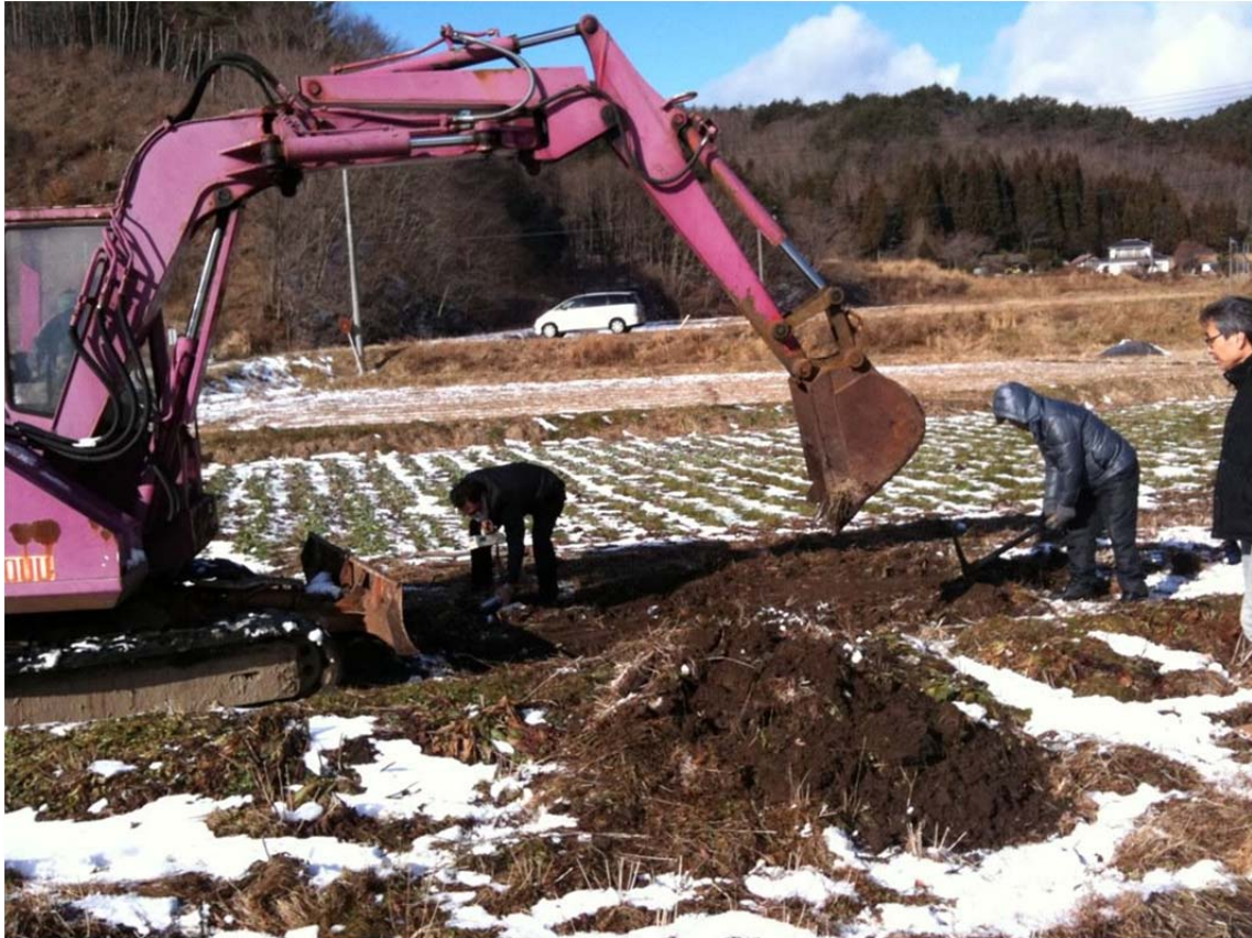
写真1 飯舘村佐須字滑の水田における凍土剥ぎ取り実証実験（2012 年 1 月 8 日）
