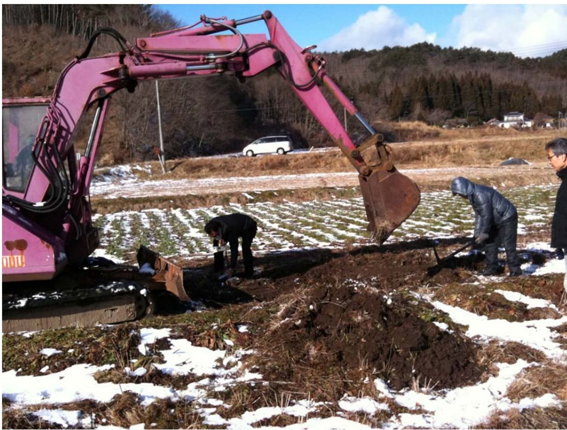
写真1 飯館村佐須字滑の水田における凍土剥ぎ取り実証実験 (2012年1月8日)
