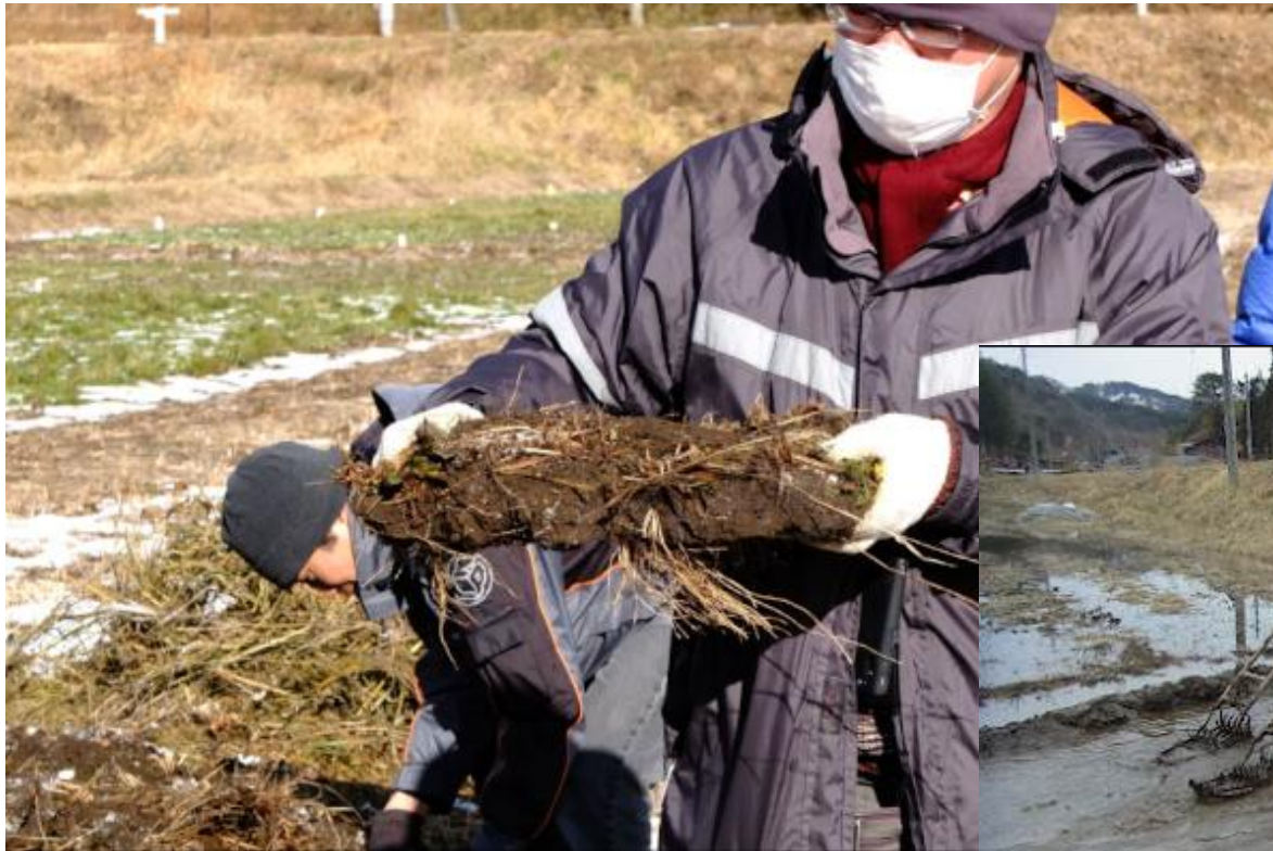
凍土剥ぎ取りによる農地除染 (2012年1月)
