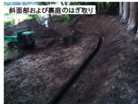
除染が完了した西側部 (画面左中央の地下部分に埋設済)
