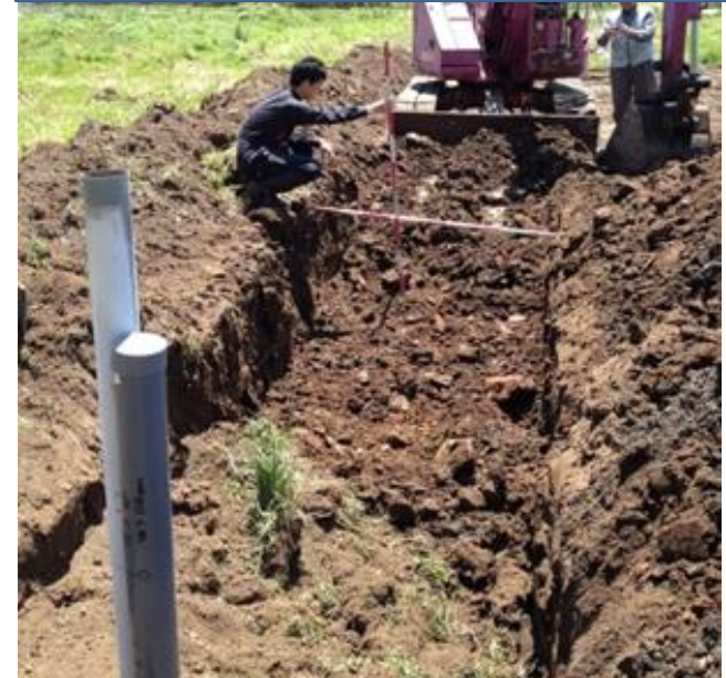
までい工法による汚染土の埋設 2014.5.18
