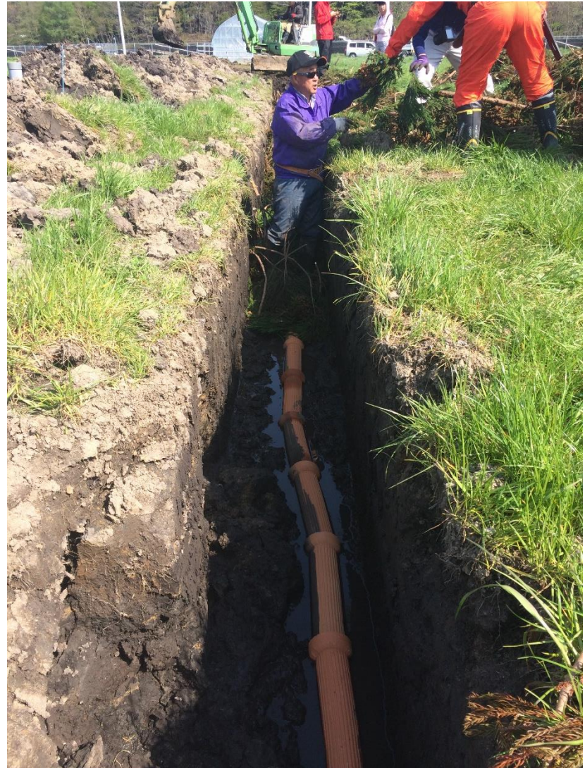
暗渠工事一飯館村松塚地区 (2018.4-28-29)
