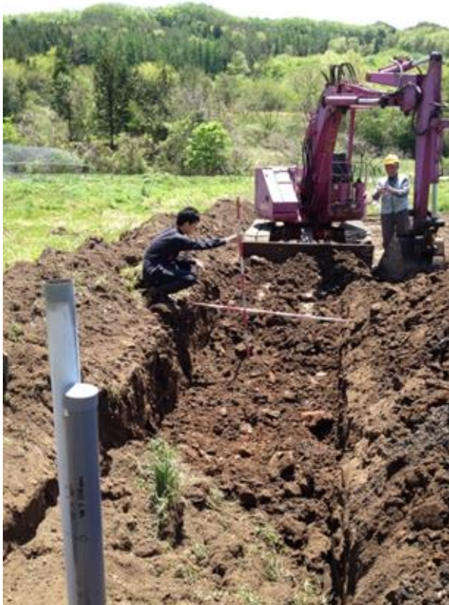
汚染土の埋設(2014.5.18)
