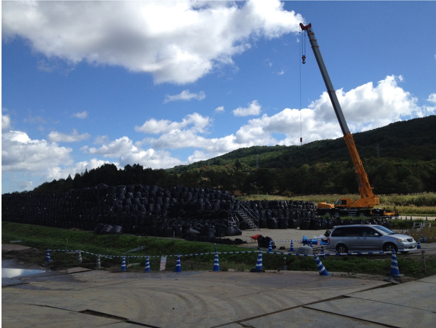
除染の工事現場（2014.10.7 二枚橋）
