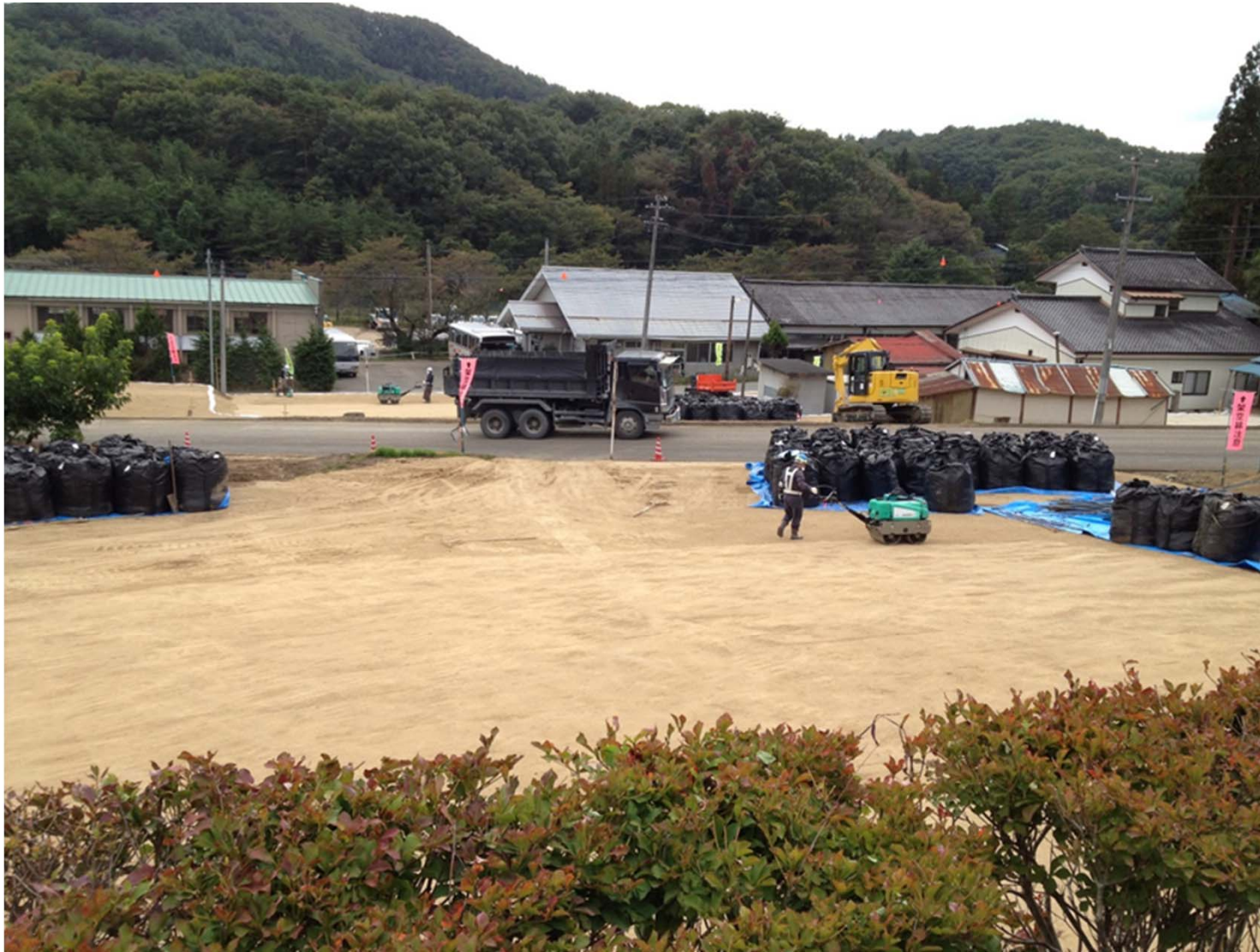
住宅除染の工事現場（2014.10.4 佐須）
