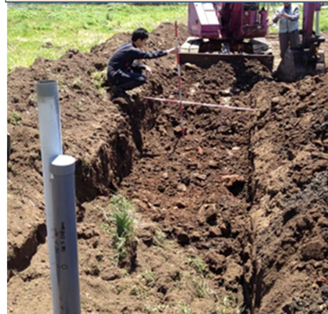
までい工法による汚染土の埋設 2014.5.18
