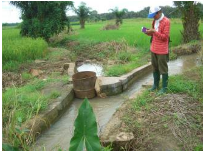
図 8. コンクリートで補強された水路
