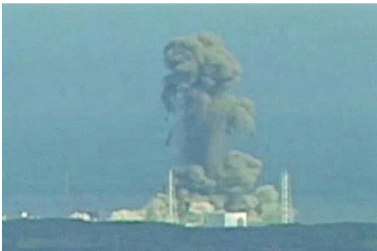
図1. 福島第一原子力発電所3号炉が水蒸気爆発もしくは核爆発した瞬間
