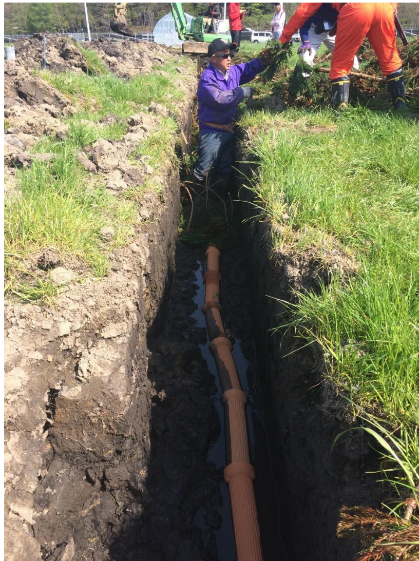
暗渠工事一飯館村松塚地区 (2018.4-28-29)
