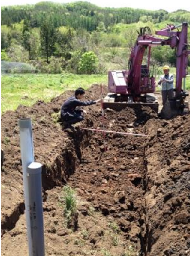
汚染土の埋設(2014.5.18)
