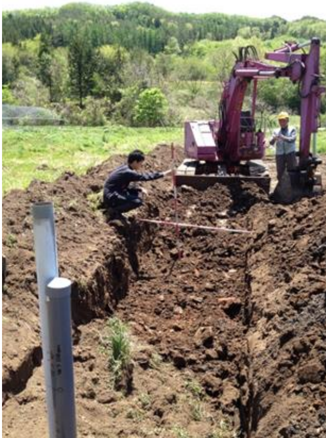
汚染土の埋設(2014.5.18)
