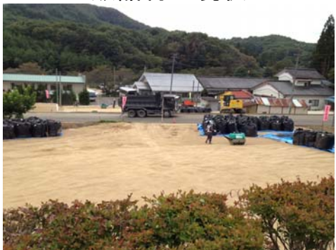
住宅除染の工事現場 (2014.10.4 佐須)
