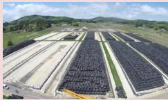
除染で劣化した農地
