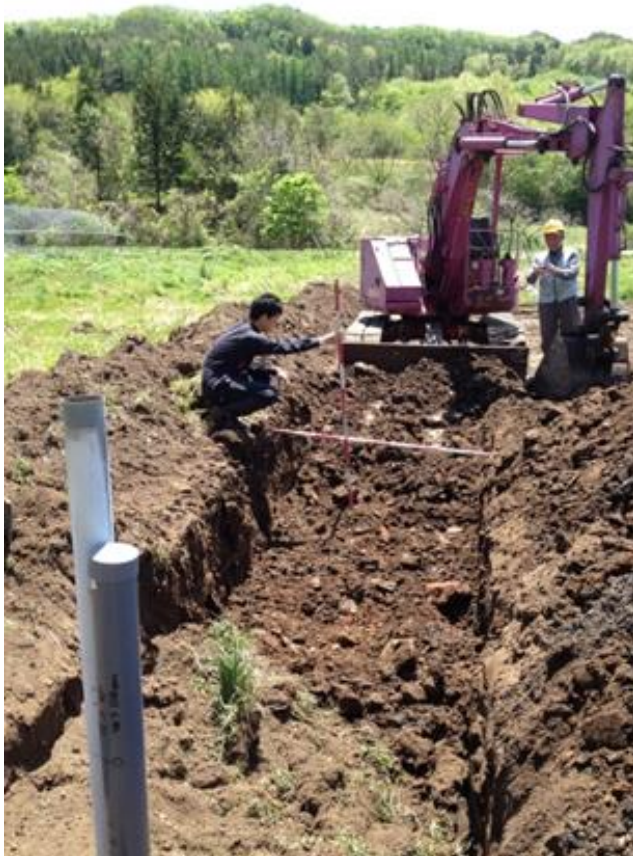
汚染土の埋設(2014.5.18)
