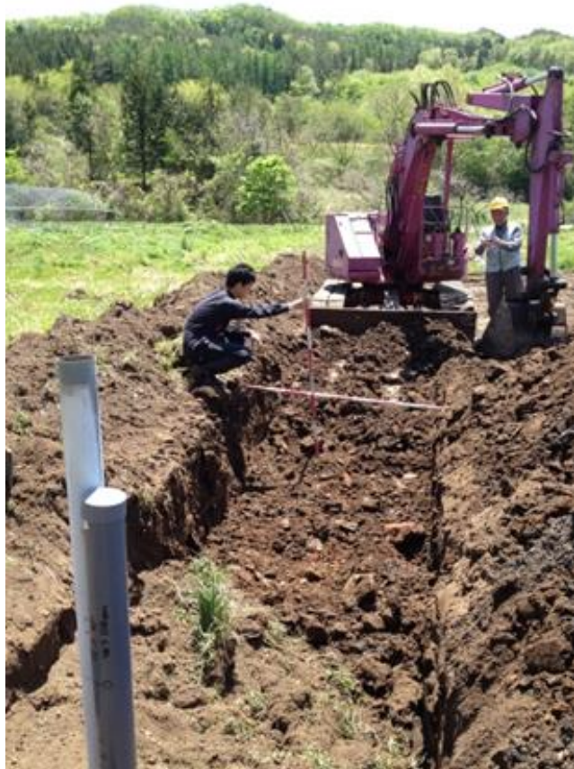
汚染土の埋設(2014.5.18)
