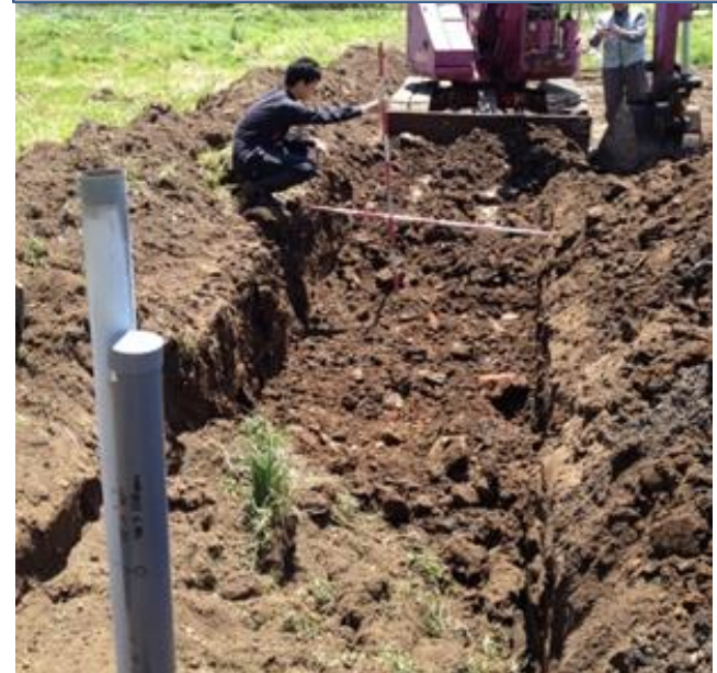
までい工法による汚染土の埋設 2014.5.18
