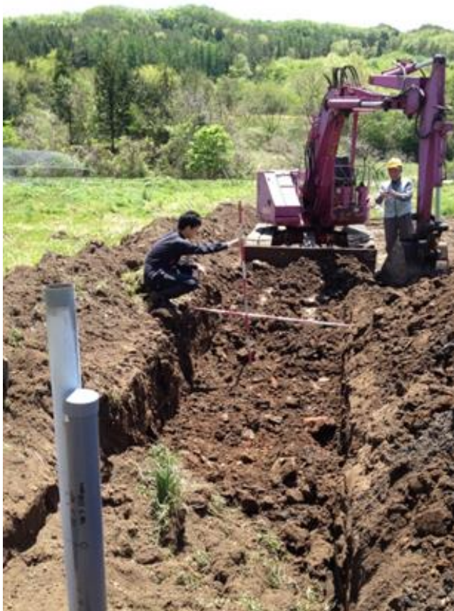
汚染土の埋設(2014.5.18)
