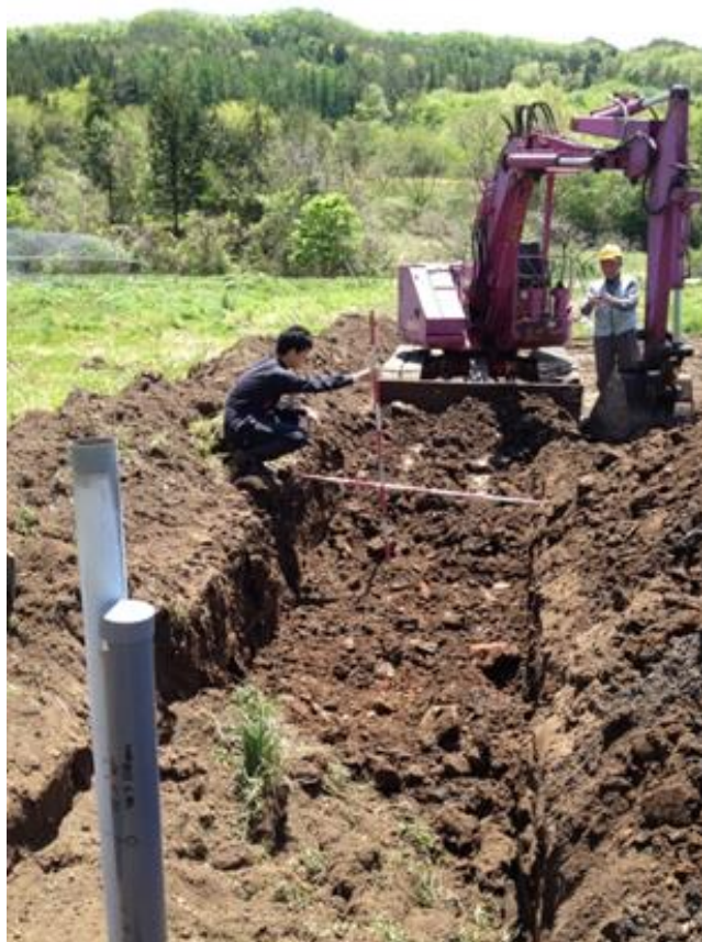
汚染土の埋設(2014.5.18)
