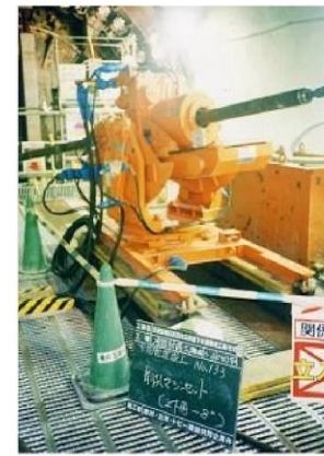
凍結管理設状況
