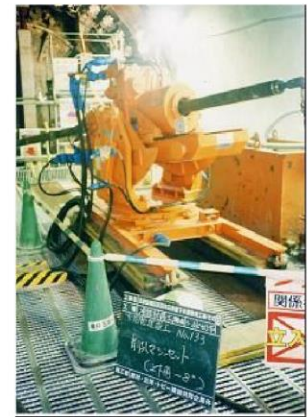
凍結管埋設状況
