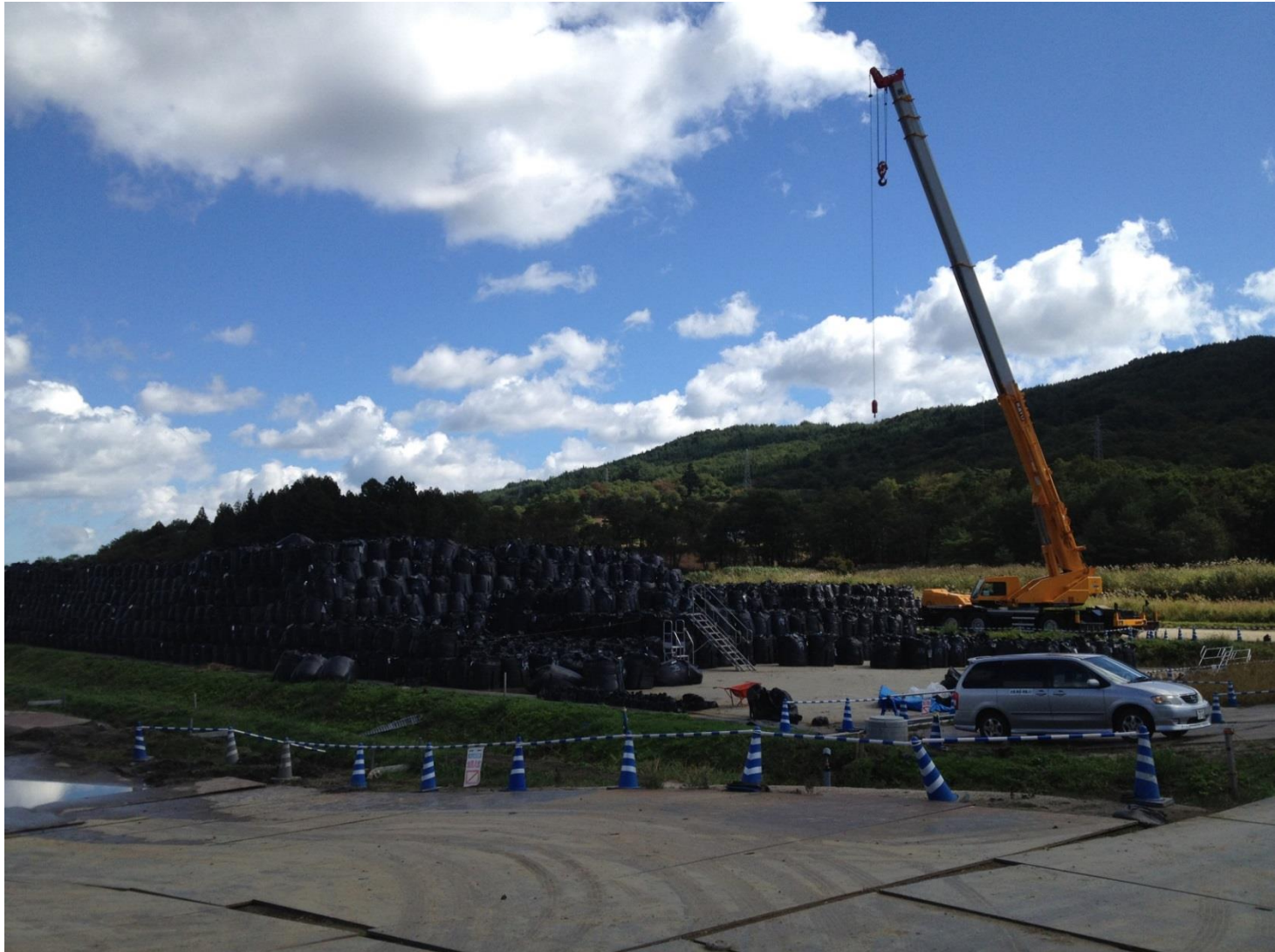
除染の工事現場（2014.10.7 二枚橋）
