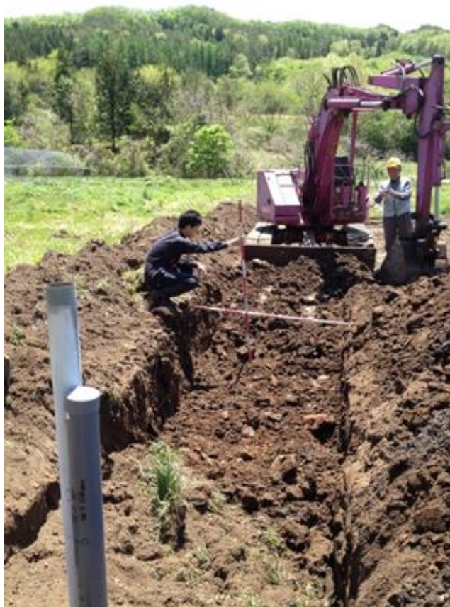
汚染土の埋設(2014.5.18)
