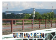
農道橋の監視
