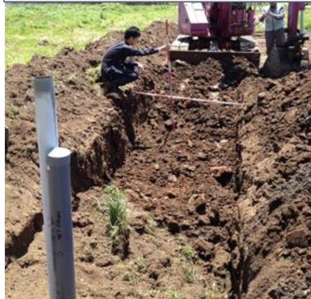
までい工法による汚染土の埋設 까지 공법에 의한 오염토 매립 공법 2014.5.18
