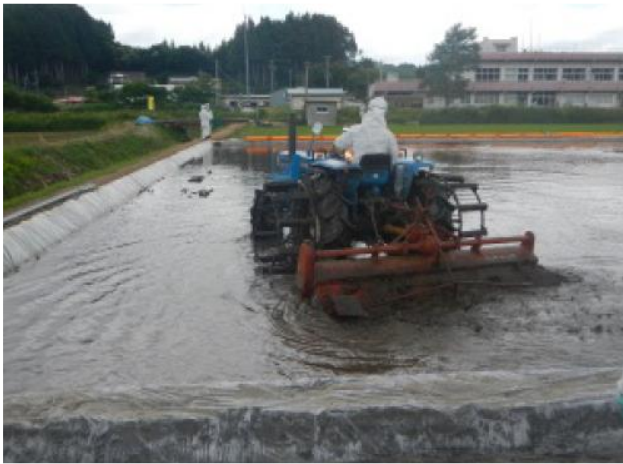
水による土壌攪拌・除去 물에 의한 토양 교반 및 제거
