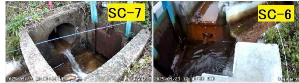
Fig.4 Wi-Fi カメラによる水門監視
