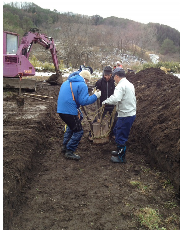
Photo-1 汚染土の埋設作業(2012.12.1)
