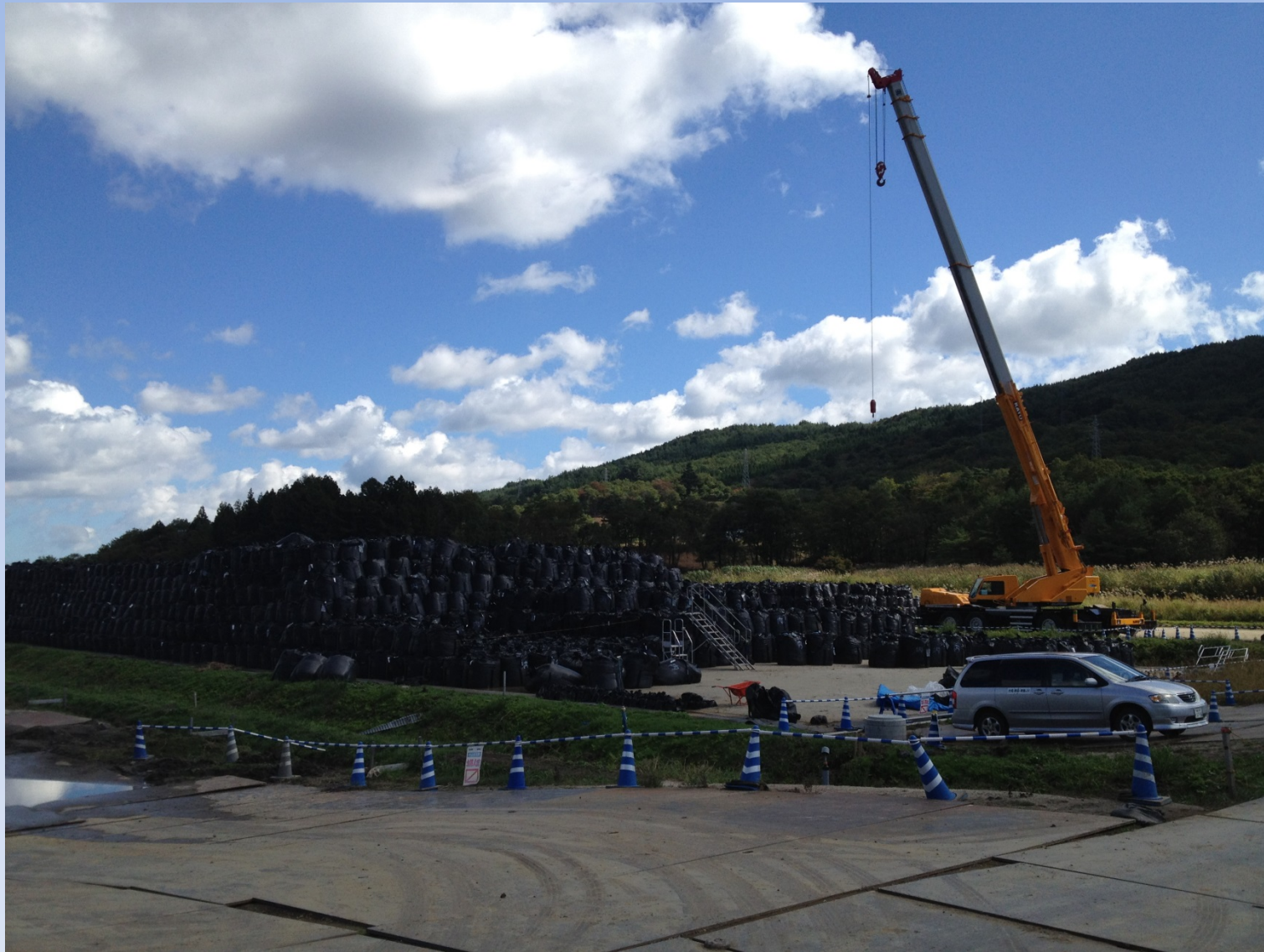
除染の工事現場（2014.10.7 二枚橋）
