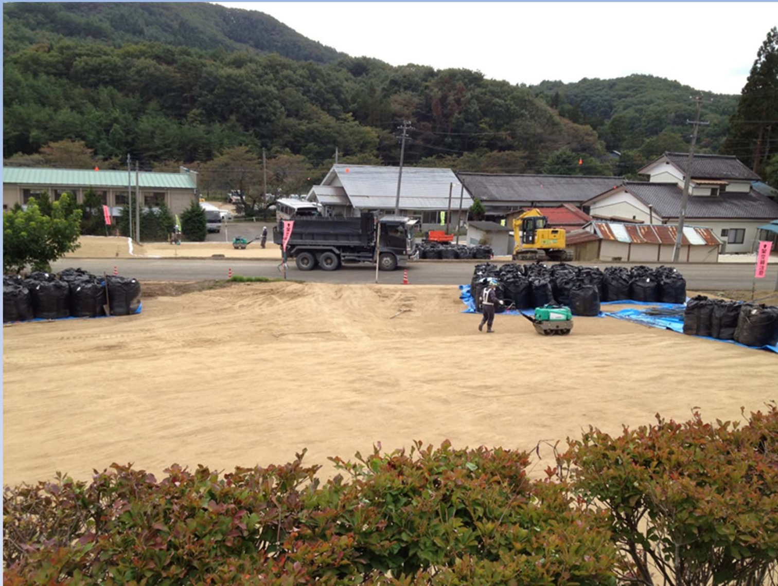
住宅除染の工事現場（2014.10.4 佐須）
