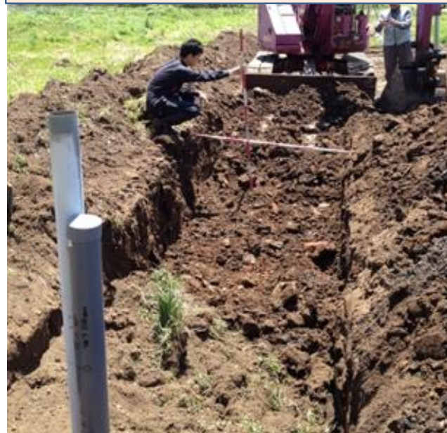
までい工法による汚染土の埋設 2014.5.18
