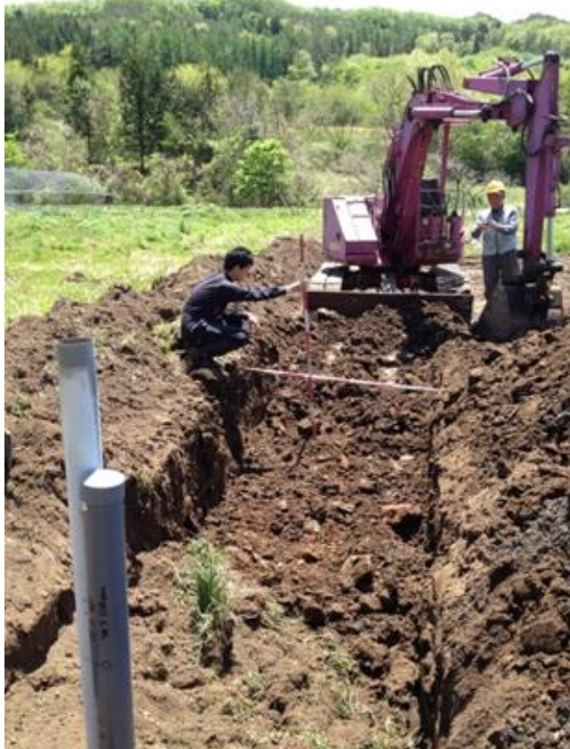
汚染土の埋設(2014.5.18)
