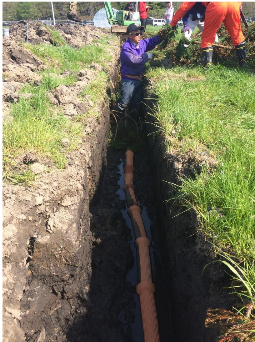
暗渠工事一飯館村松塚地区 (2018.4-28-29)
