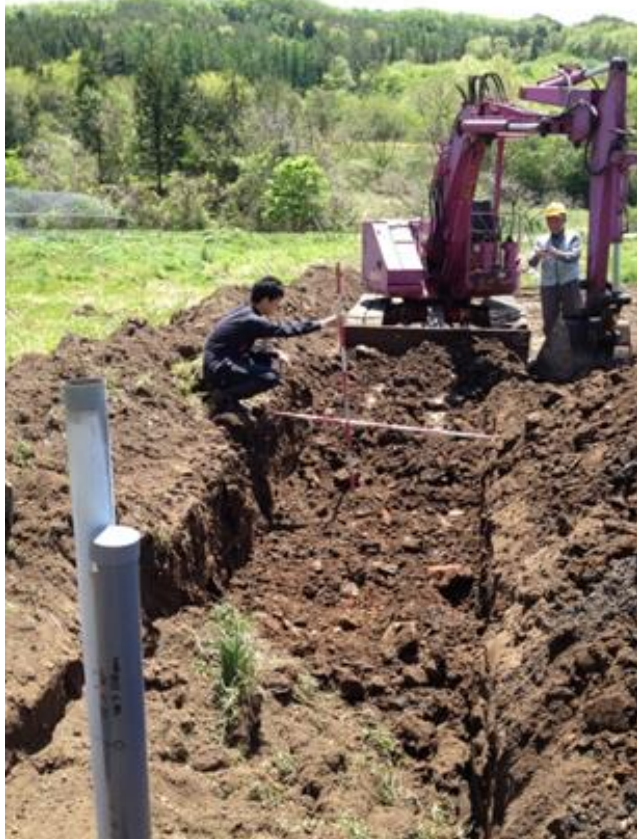
汚染土の埋設(2014.5.18)
