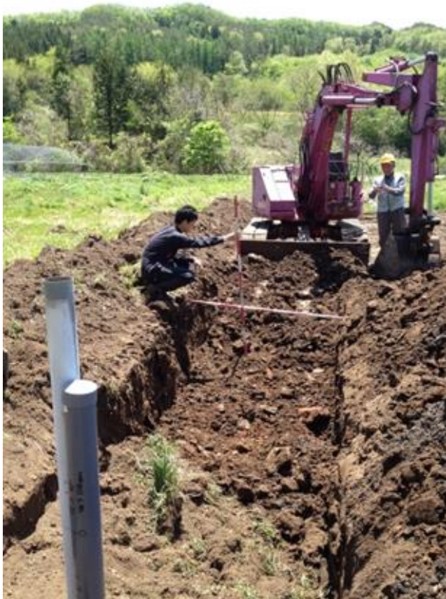
汚染土の埋設(2014.5.18)
