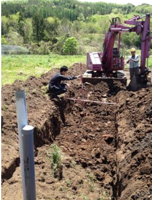
汚染土の埋設(2014.5.18)
