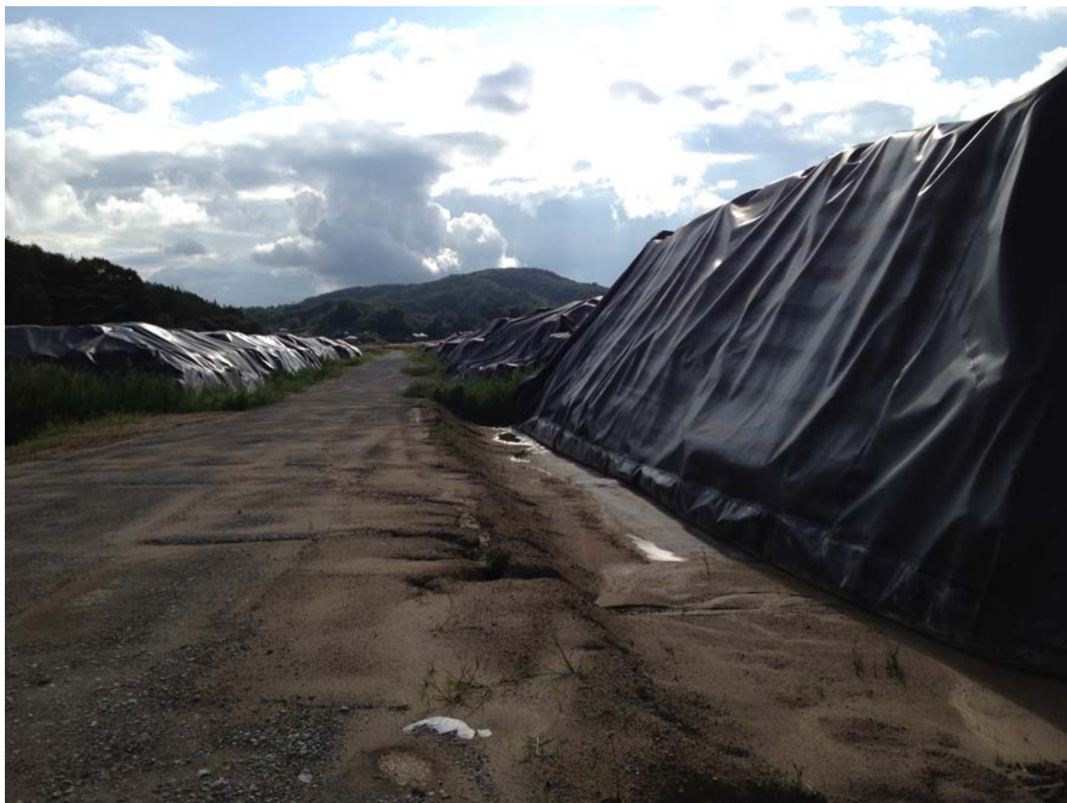
除染終了した地区の“仮仮”置場（2014.10.7 須萱）
