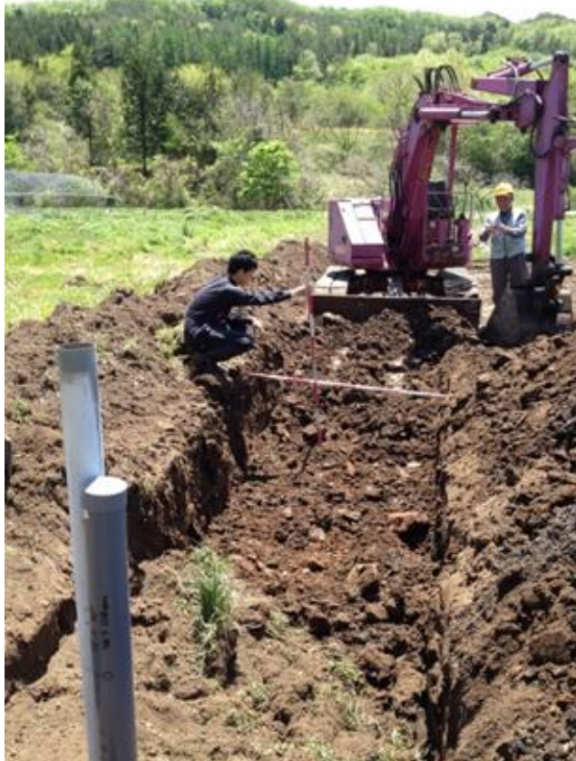
汚染土の埋設(2014.5.18)
