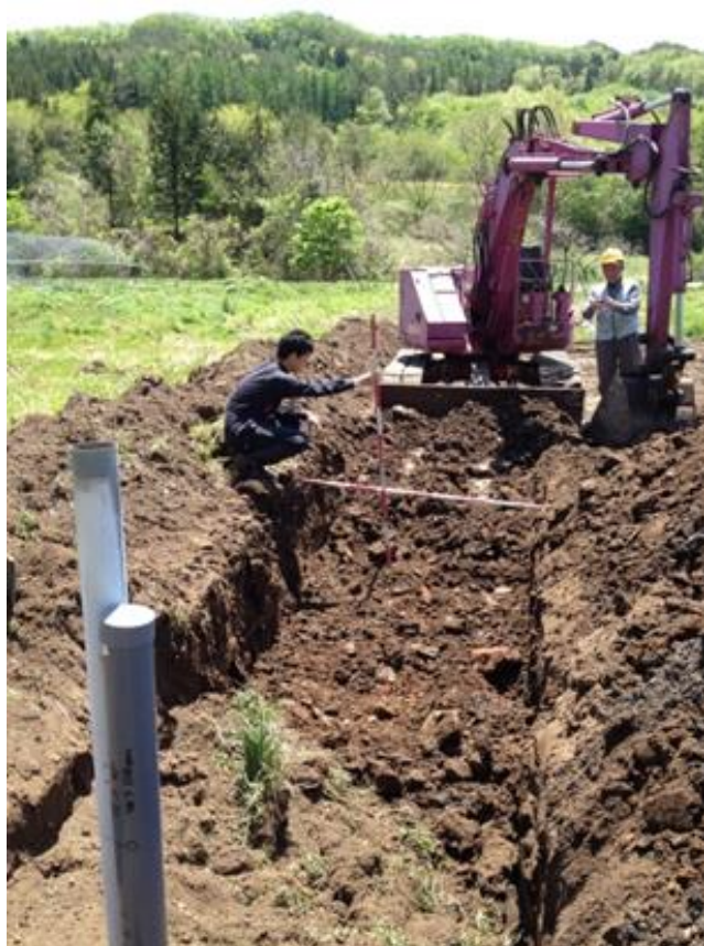
汚染土の埋設(2014.5.18)
