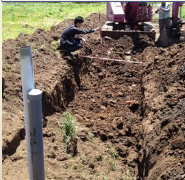
までい工法による汚染土の埋設 2014.5.18
