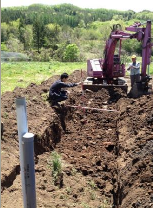
汚染土の埋設(2014.5.18)
