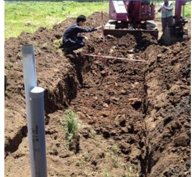
までい工法による汚染土の埋設
