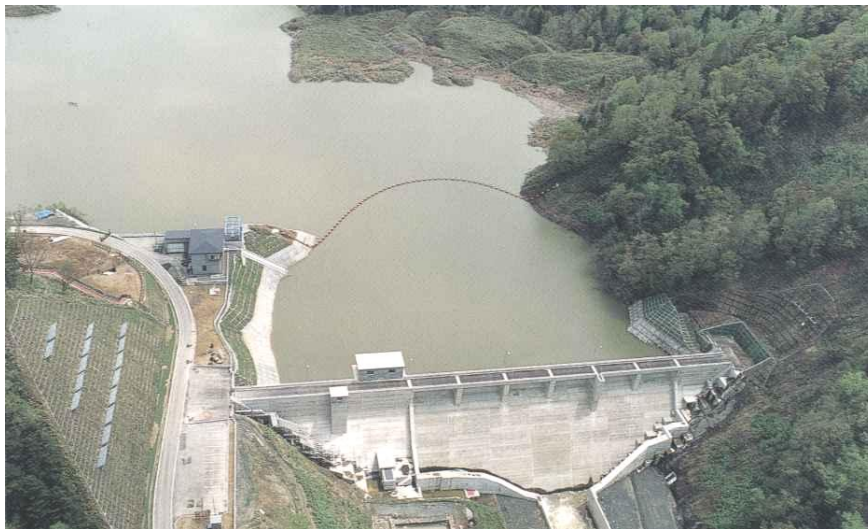
苫前ダム(国営かんがい排水事業「苫前(二期)地区」，北海道) 日本ダム協会HPより
