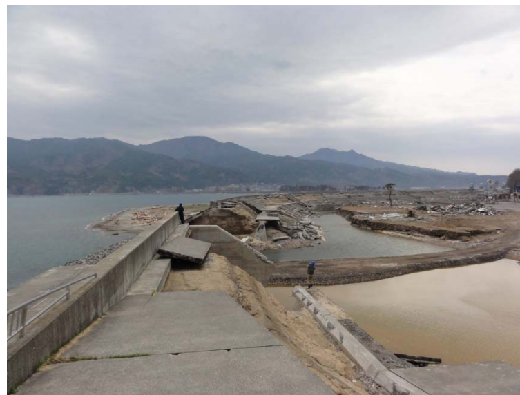
宮古市金浜海岸 粘り強い堤防
