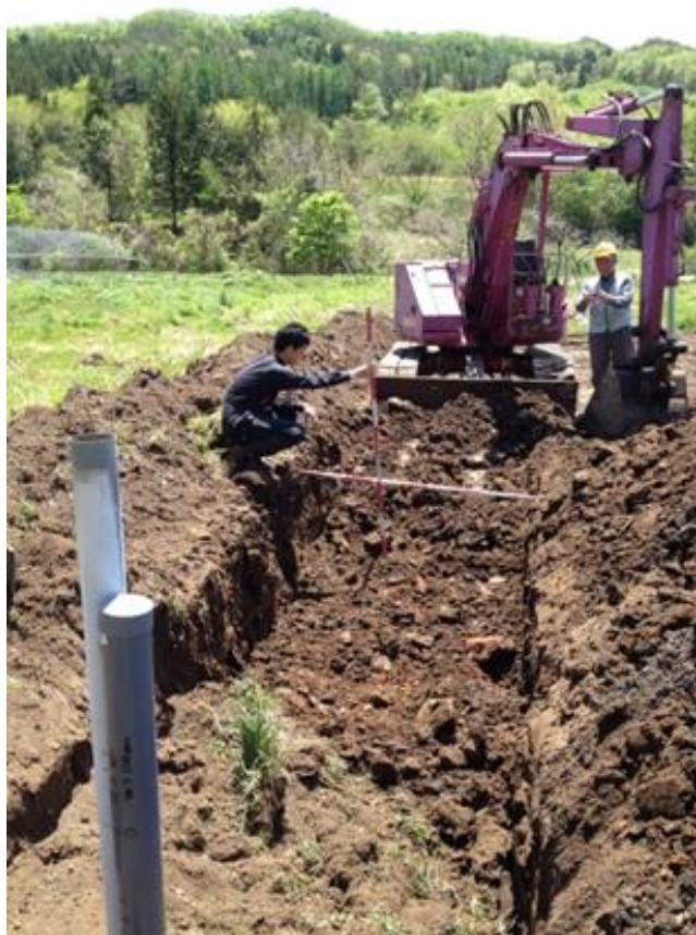
汚染土の埋設(2014.5.18)
